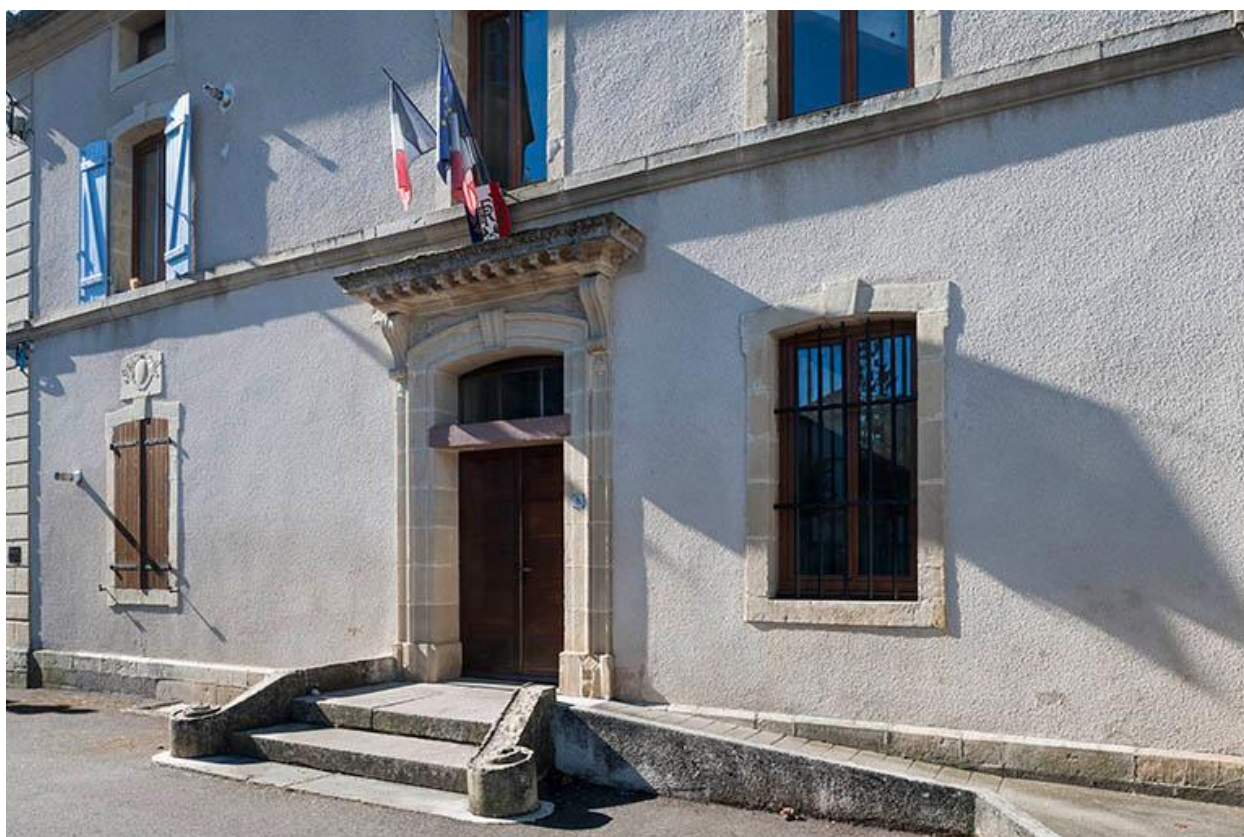
Entrée de la mairie, façade Nord.
