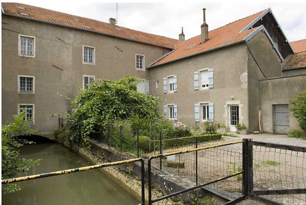
Façade postérieure et canal d'amenée.
