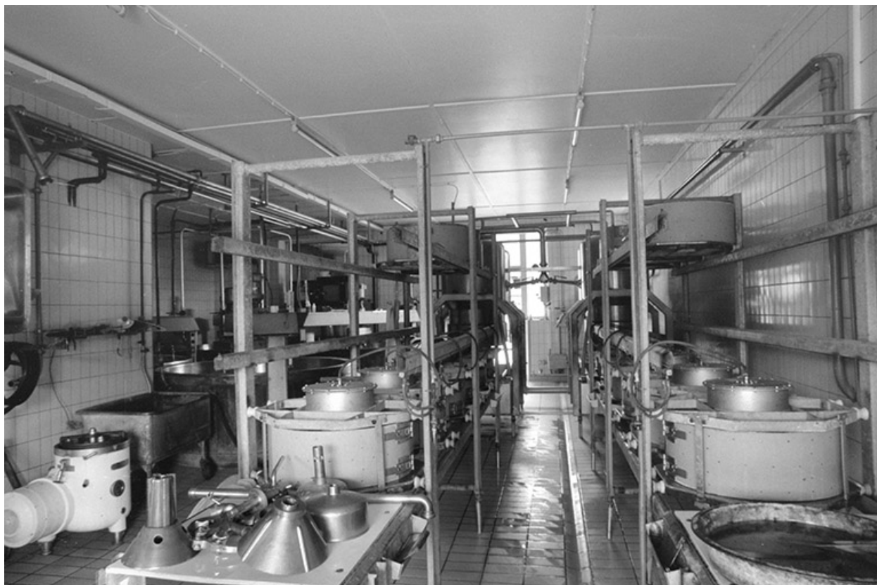
Intérieur de l'atelier de fabrication.
