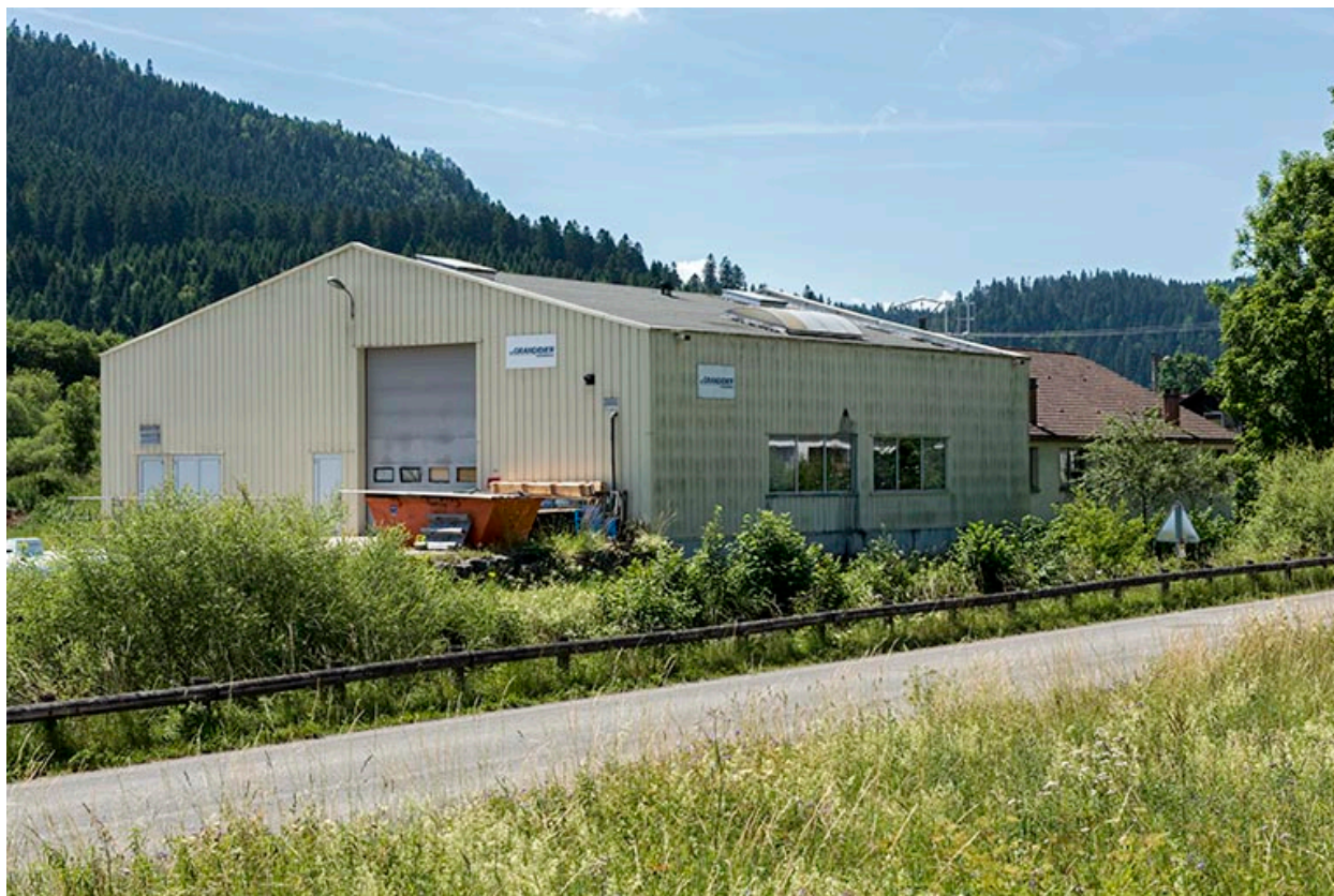
Façades postérieure et latérale droite.
