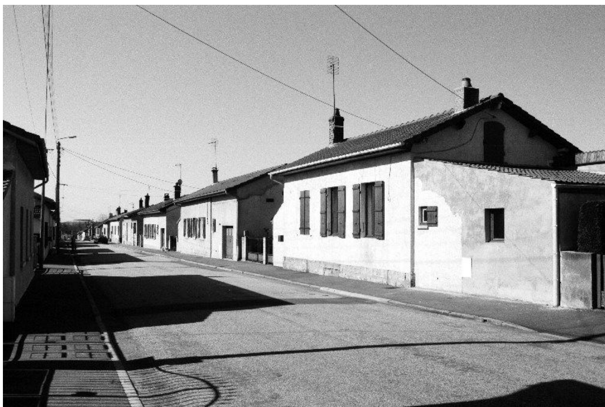
Logements ouvriers construits en 1908.
