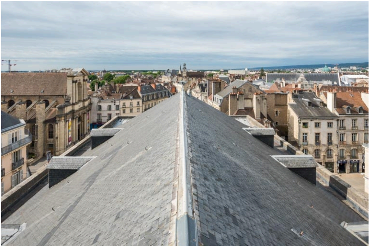
Toit au-dessus de la salle, depuis le nord.
