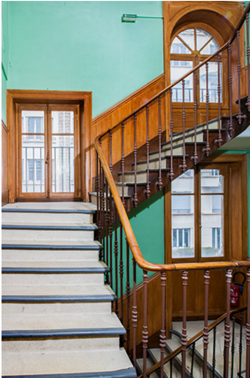
Bâtiment de l'administration, cage d'escalier : volées du 1er au 2e étage.
