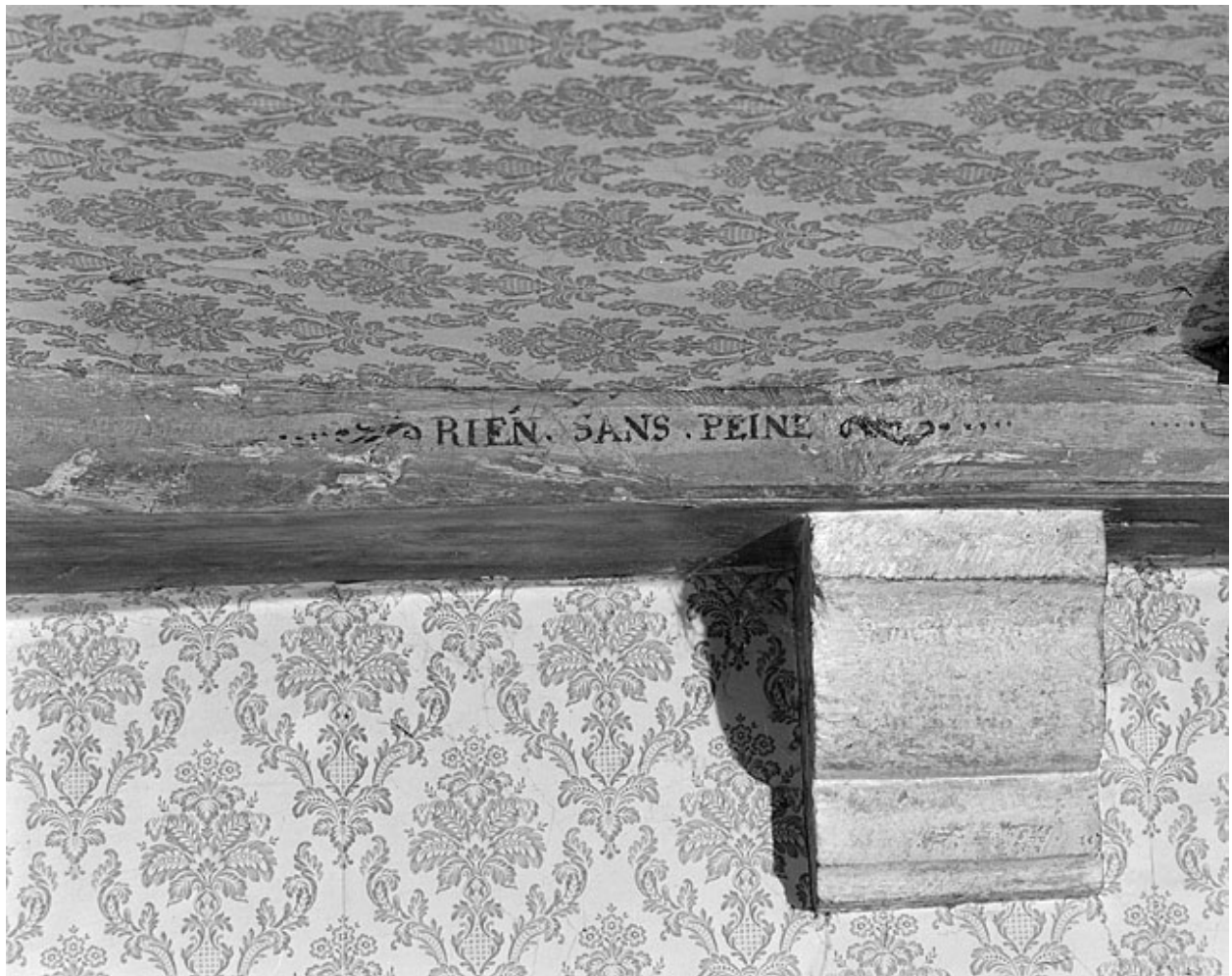
Premier corps de bâtiment. Plafond du rez-de-chaussée.
