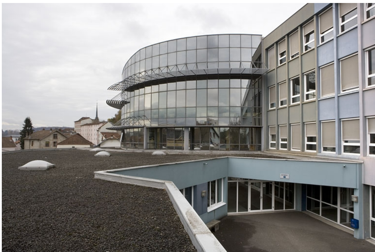
Vue tour bâtiment D depuis le toit.
