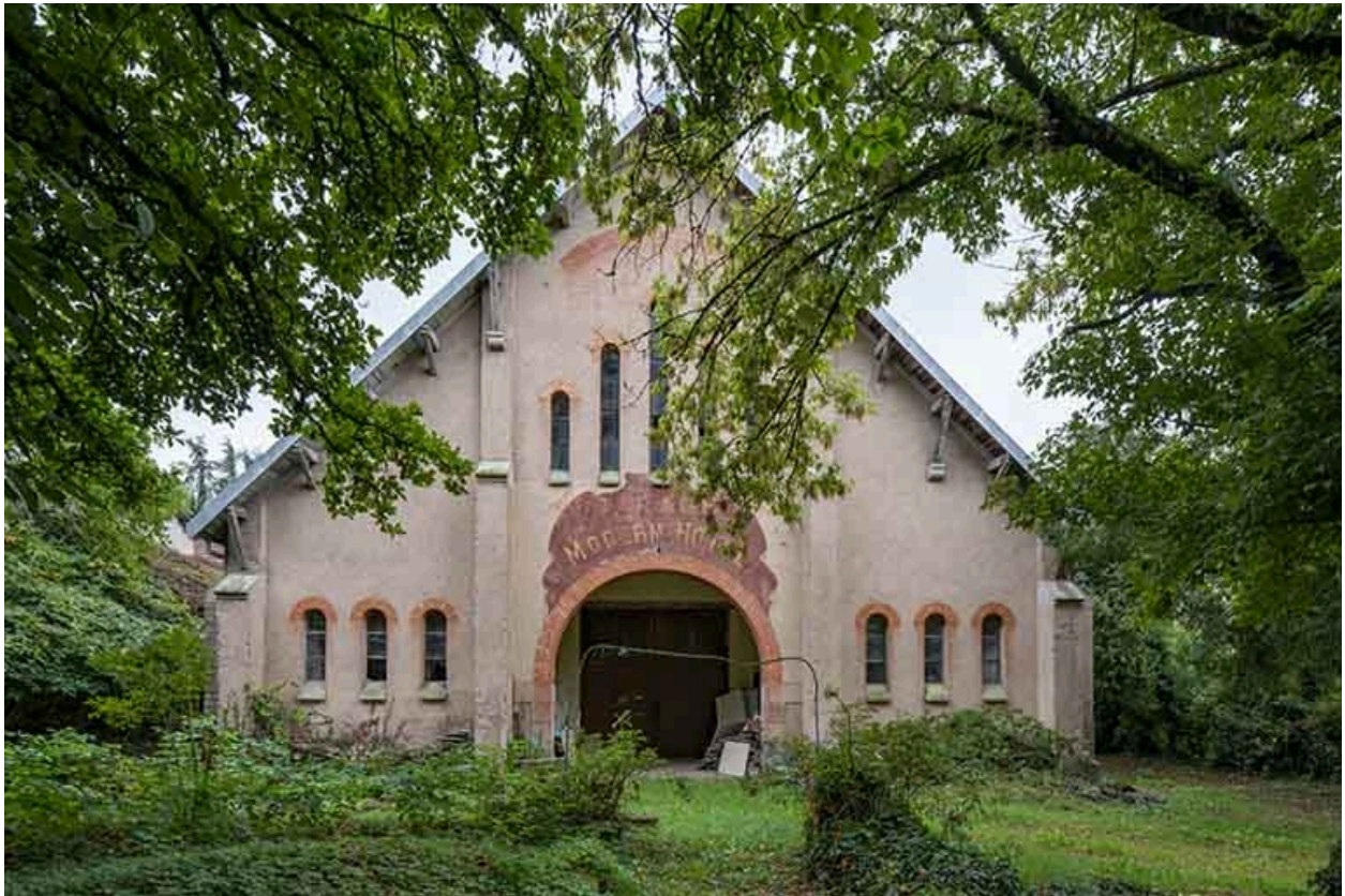
Mur-pignon nord, vue de face.
