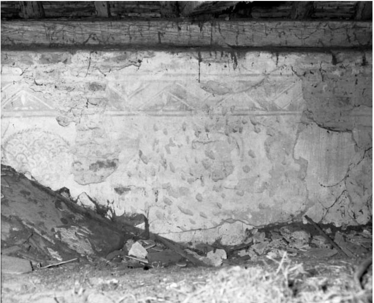
Comble de la nef, mur gauche, 4e-5e travées
