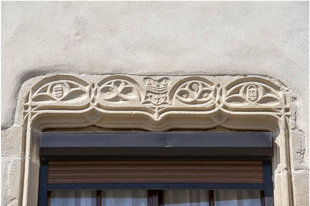
Détail du premier étage du n° 37 : linteau sculpté de la baie.
