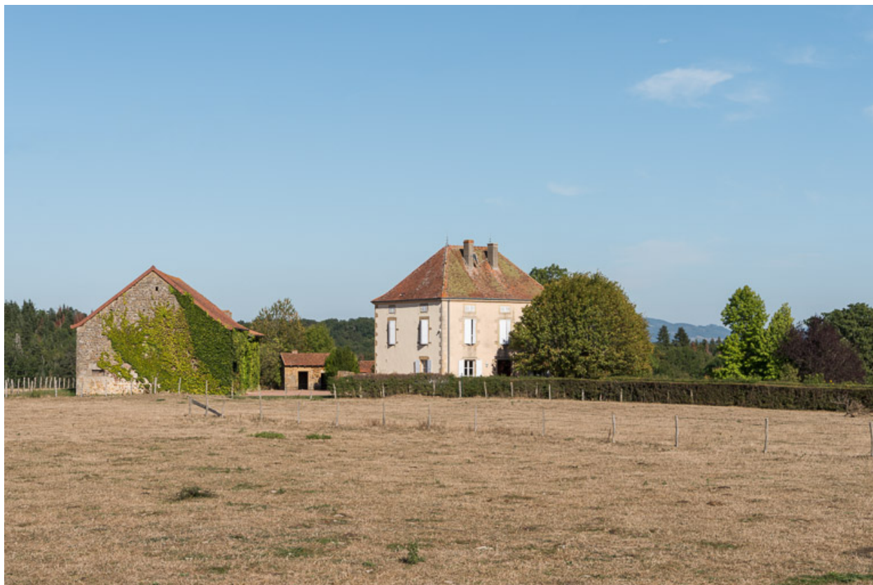
Vue de l'ancienne ferme de Parigny
