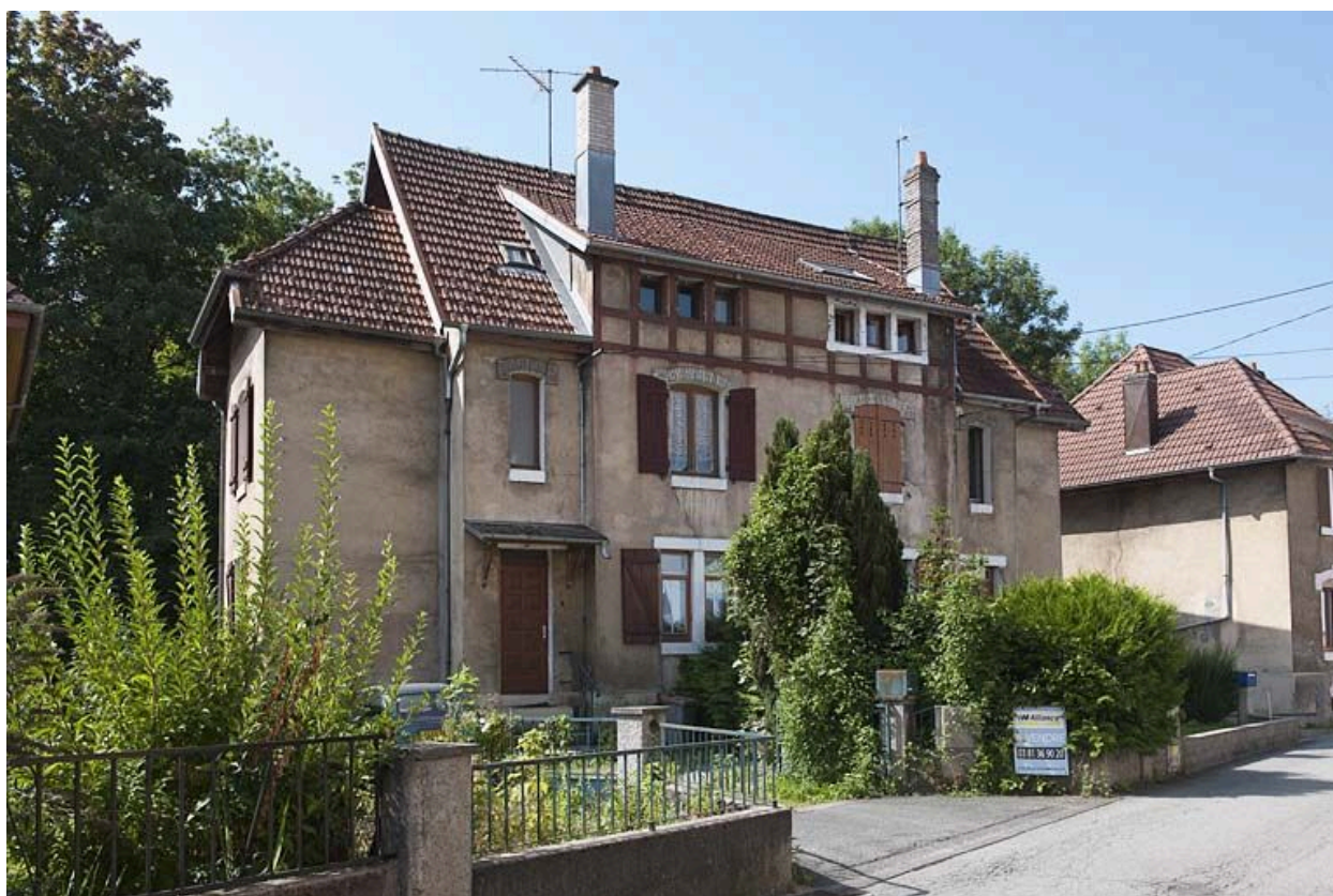
Maison jumelée rue de Flandres.
