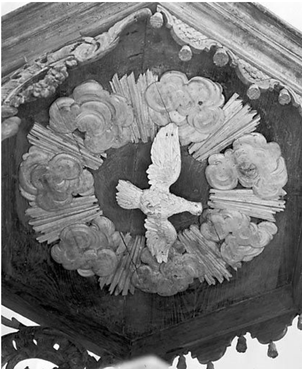
Détail : la colombe de l'abat-voix.
