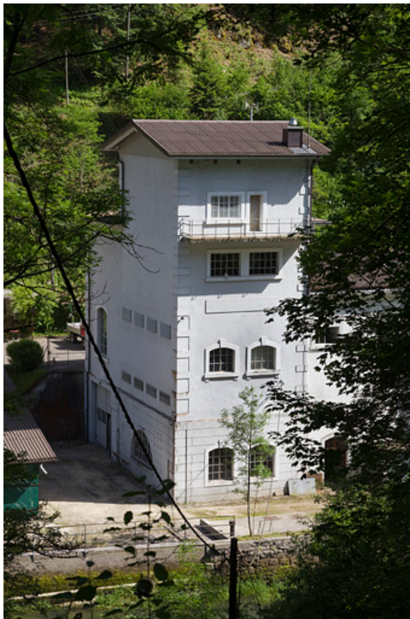
Centrale de la Goule : corps de bâtiment haut.
