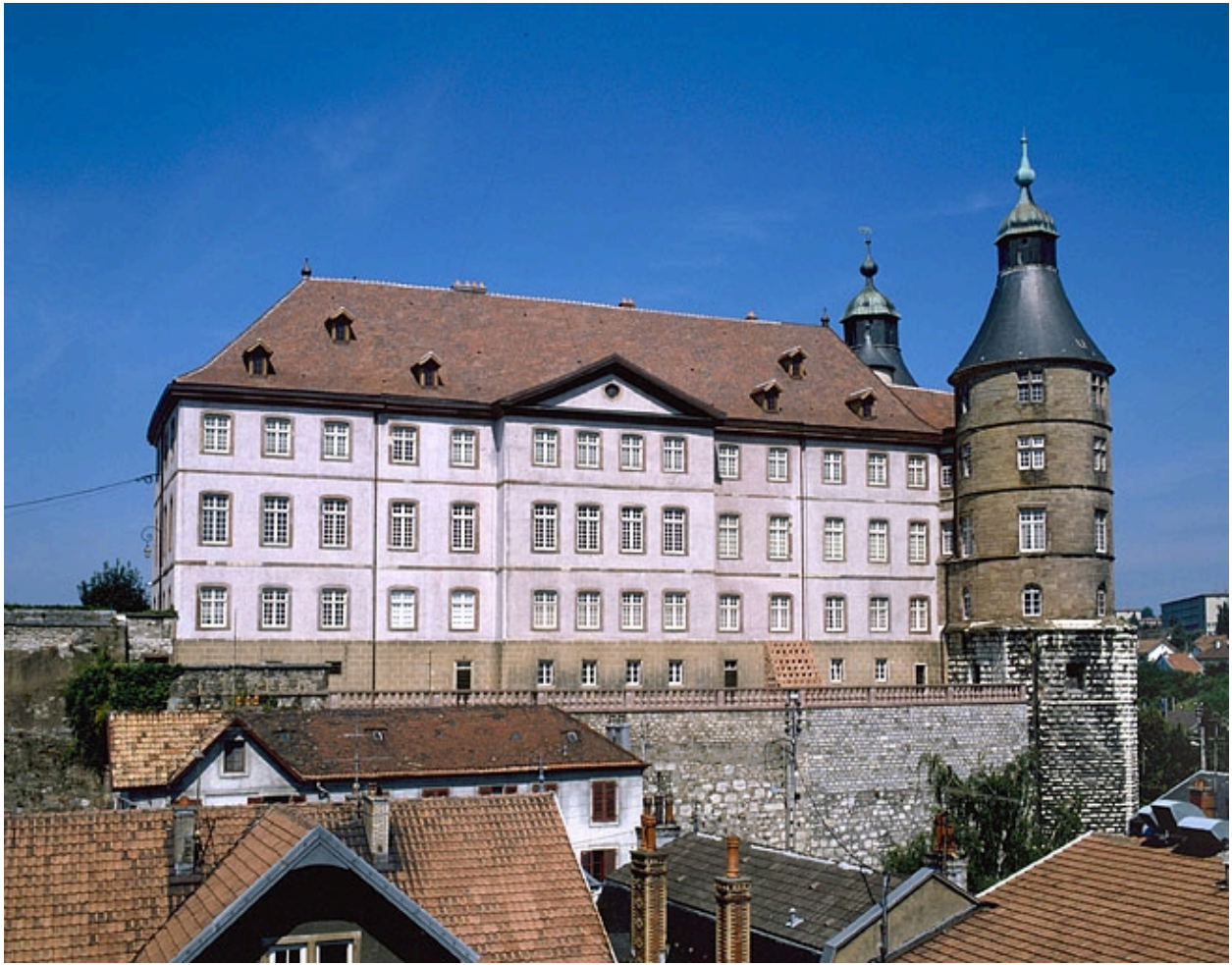
Corps de bâtiment principal. Côté sud.
