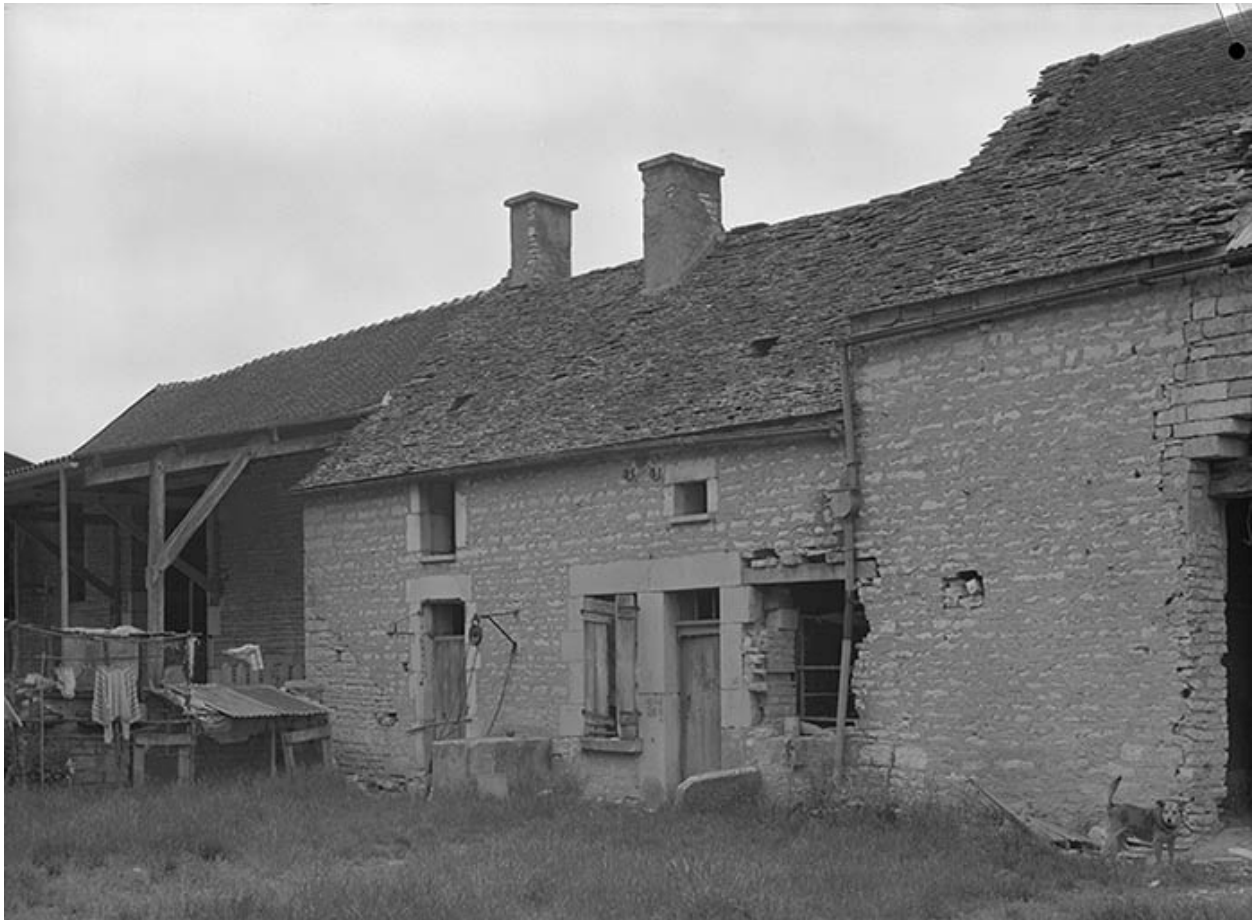
Maison et puits adossé à la façade.
