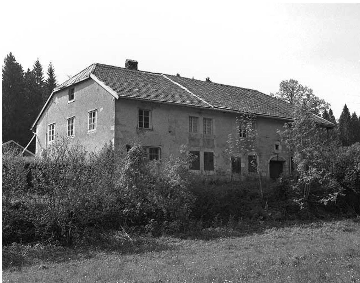
Façade postérieure vue de trois quarts gauche.
