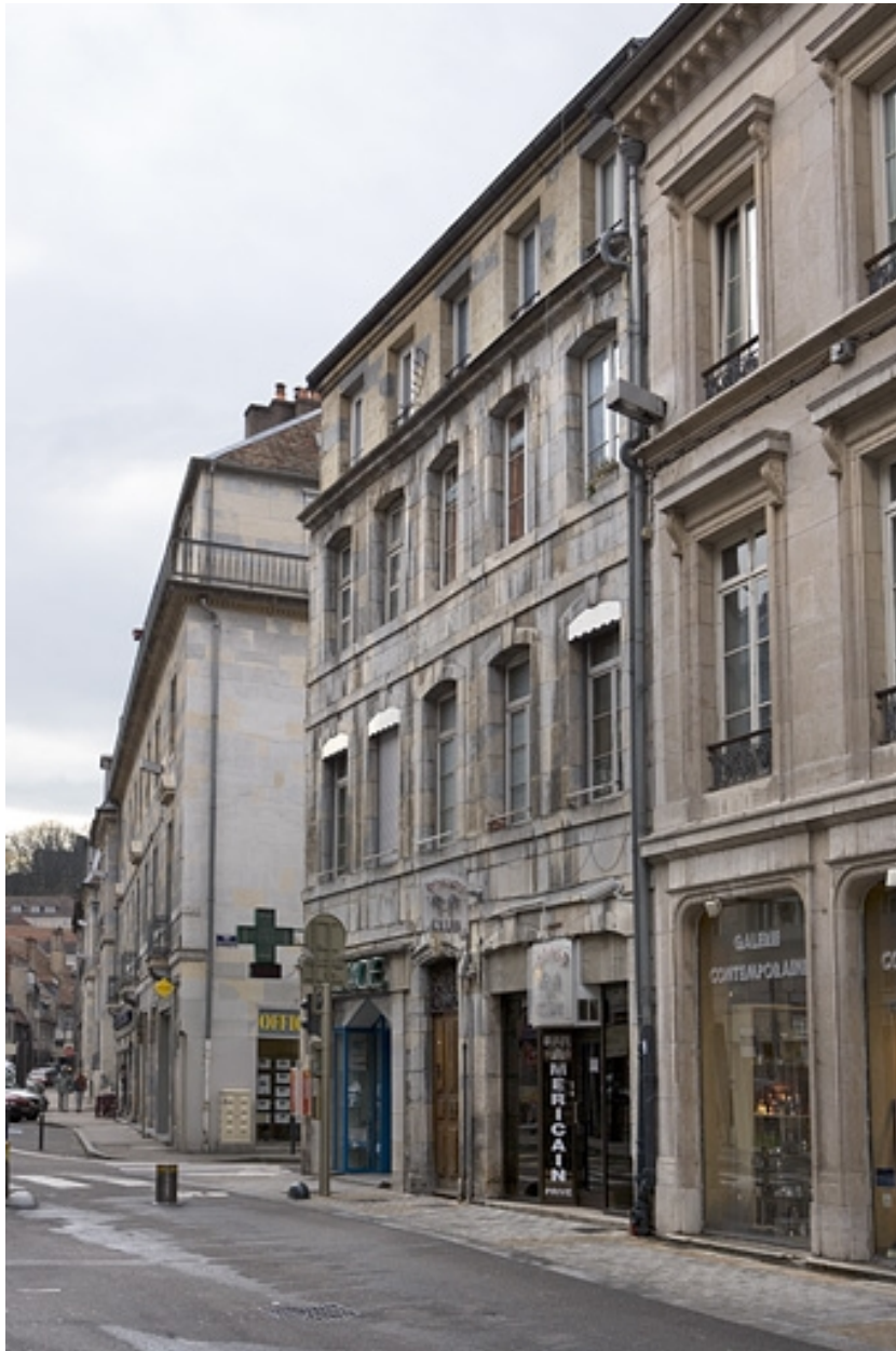
Vue d'ensemble de la façade sur rue de trois quarts droit.
