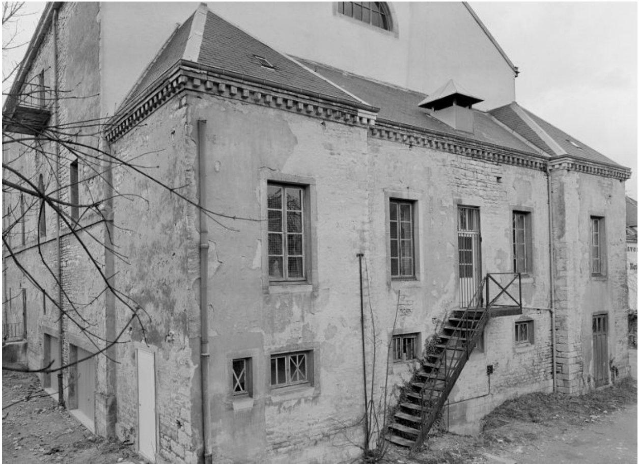
Elévation postérieure, en 1988.
