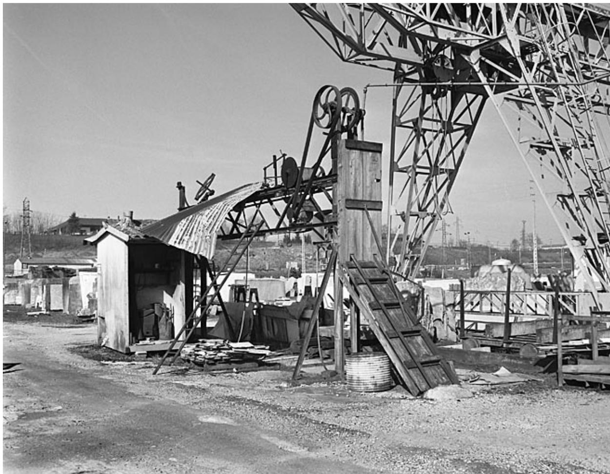
Usine de taille de matériaux de construction Célar, à Saint-Amour : scie à fil hélicoïdal.
