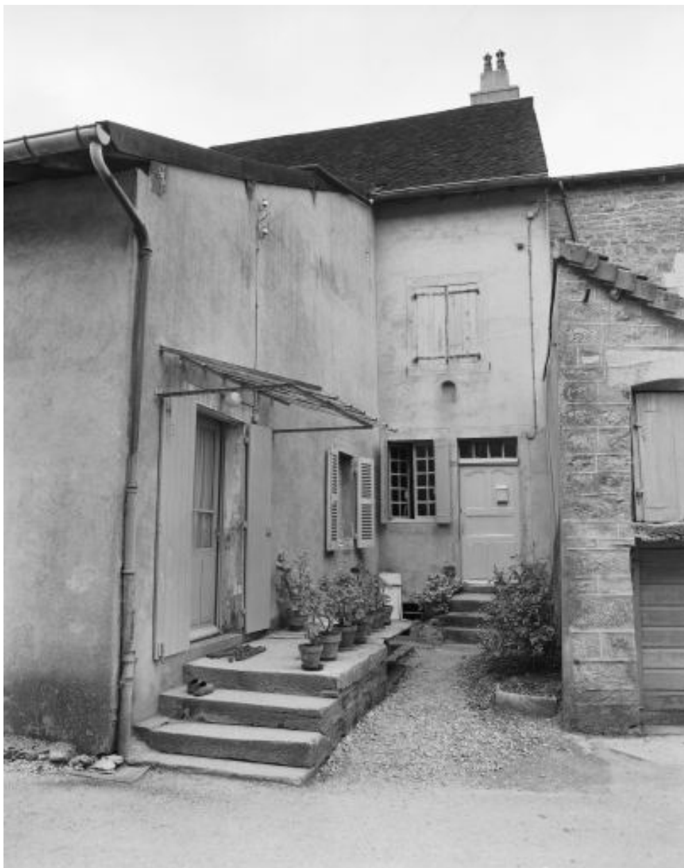
Façade sur la rue de la Forge.
