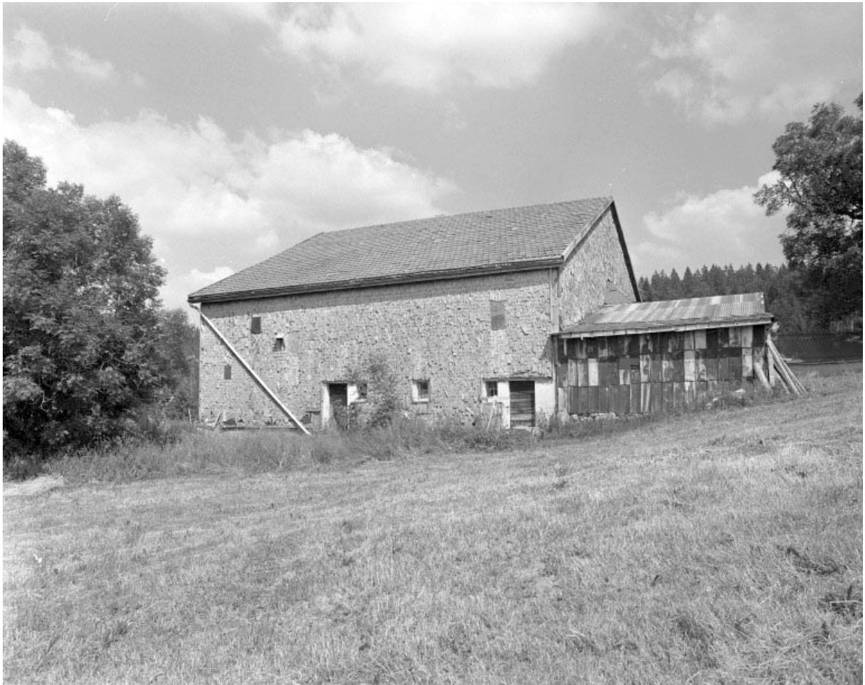
Façade postérieure couverte d'un essentage de tavaillons.
