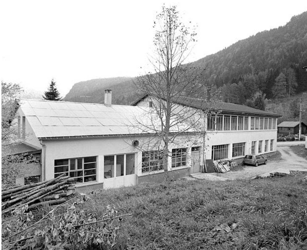
Vue d'ensemble depuis le nord : élévation postérieure.
