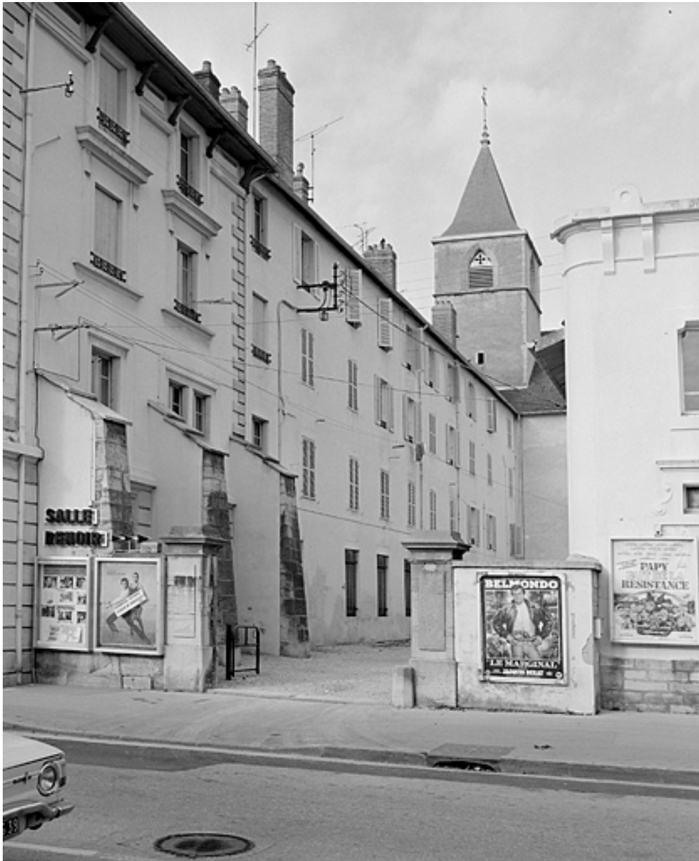
Anciens bâtiments conventuels. Façade latérale est.
