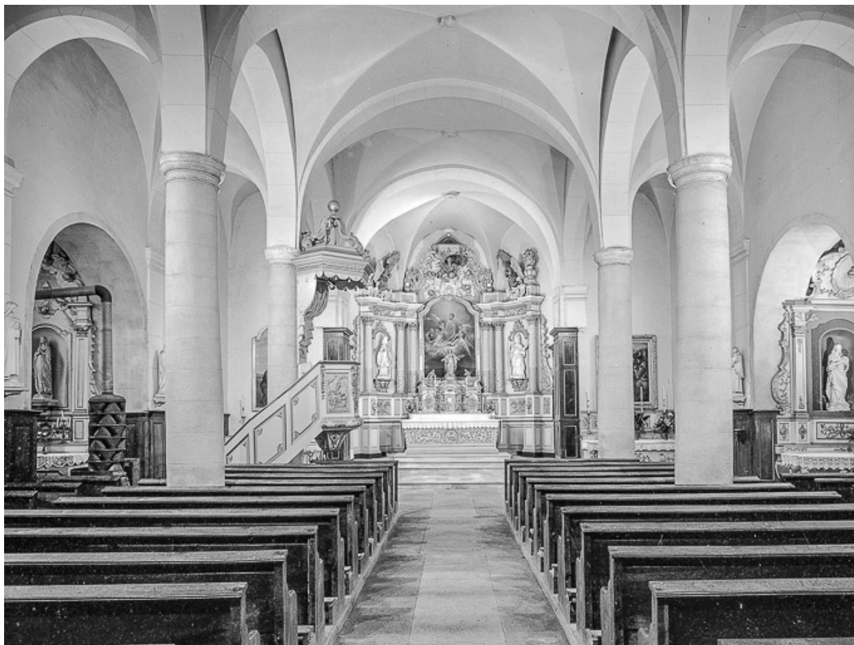
Vue de la nef et du chœur.
