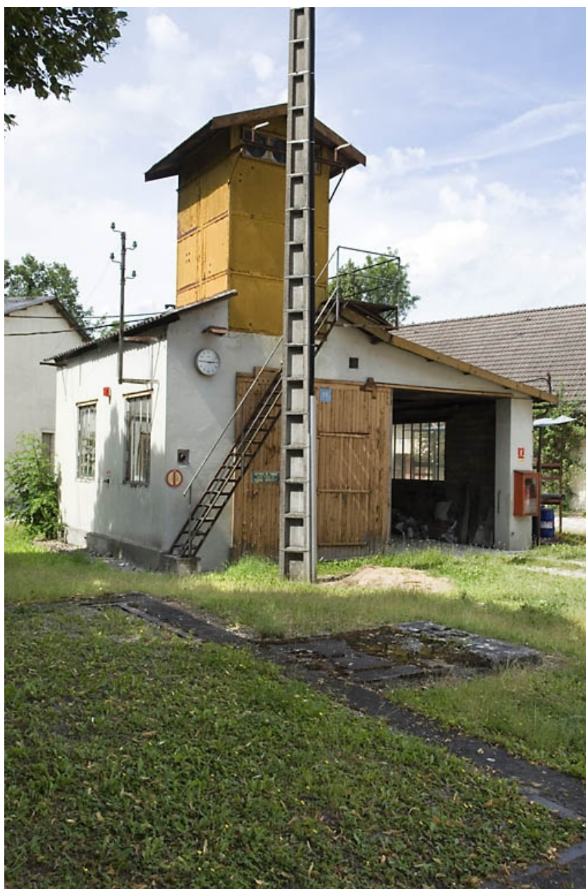
Transformateur et garage.
