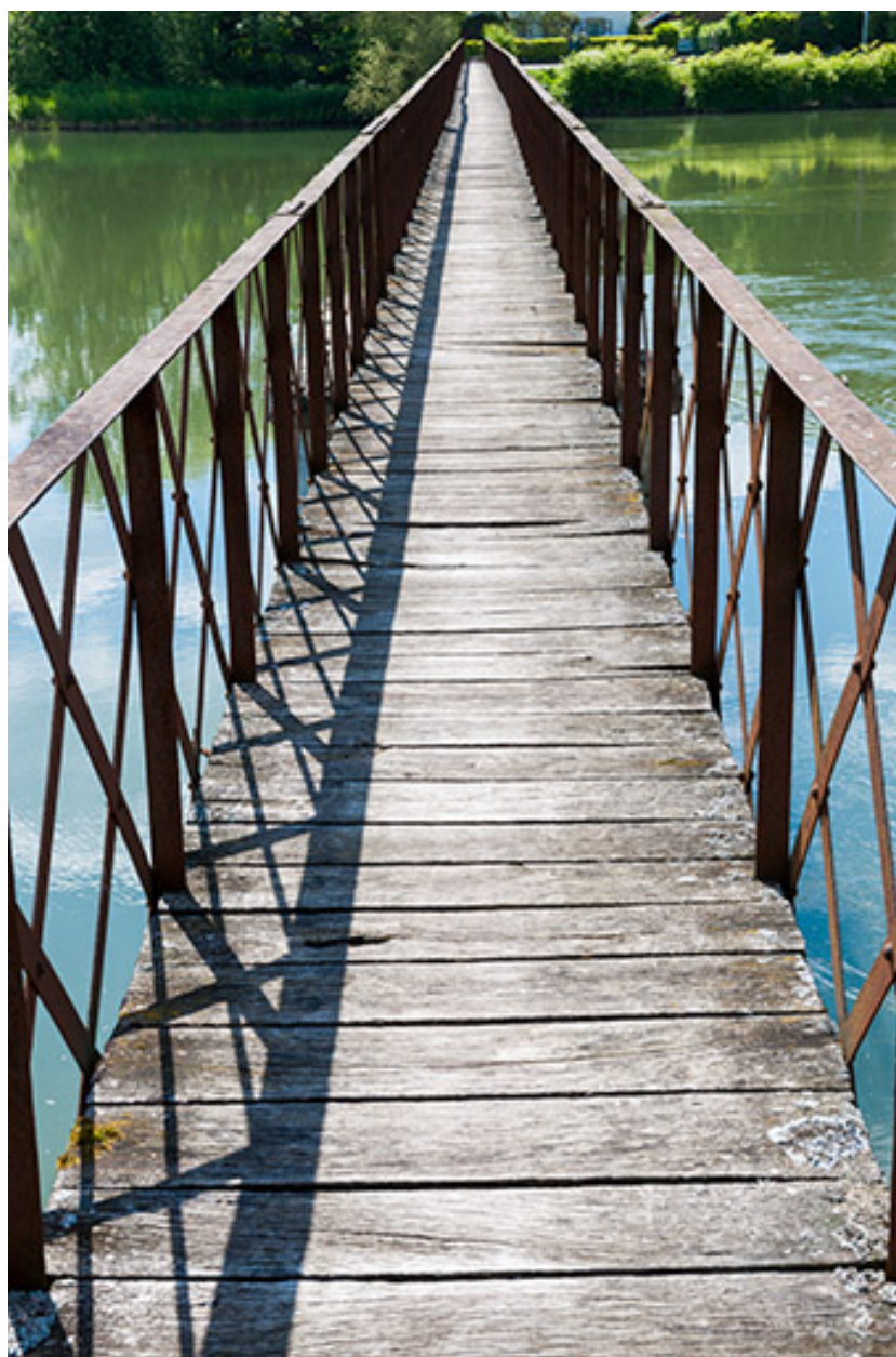
La passerelle. Vue rapprochée.
