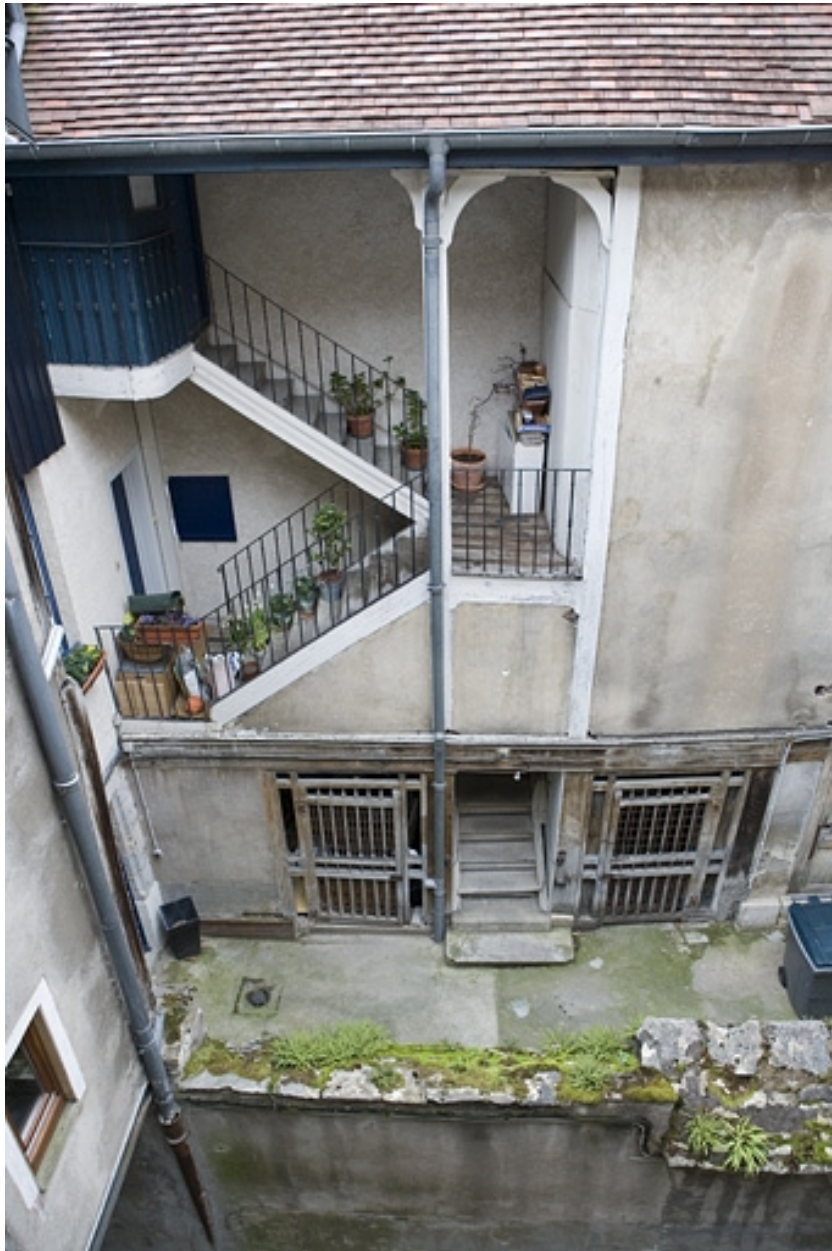
Vue plongeante sur l'escalier à cage ouverte depuis la parcelle voisine.
