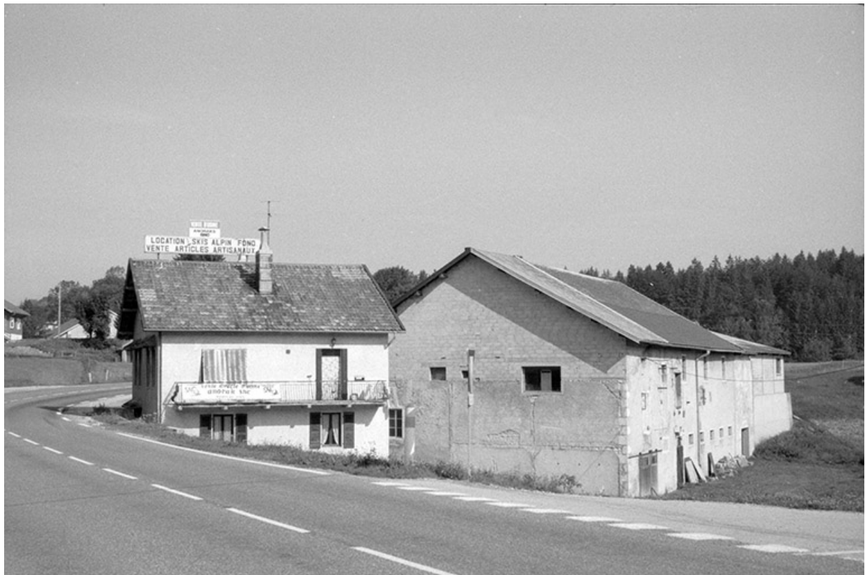
Logement patronal et ateliers de fabrication.
