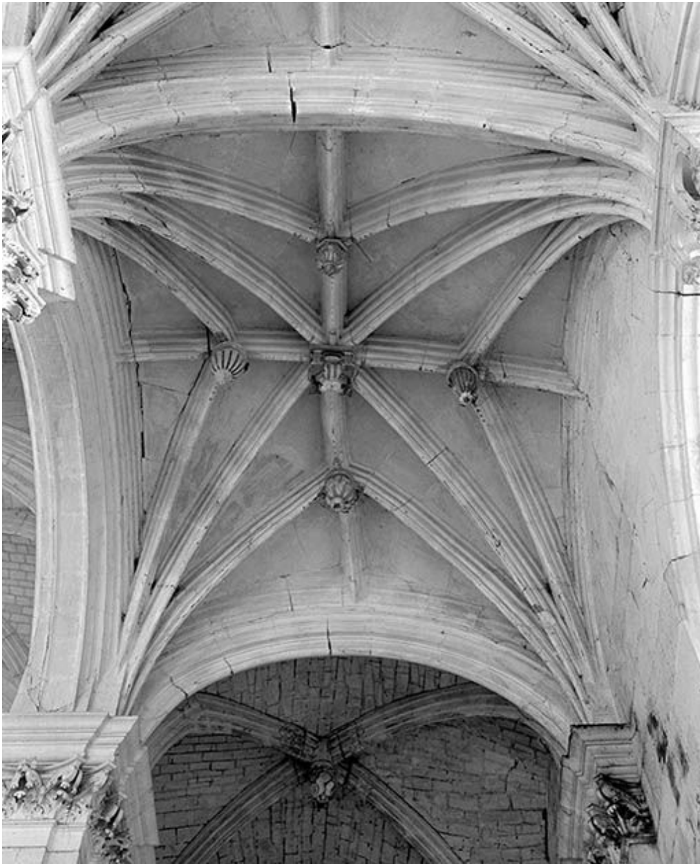
Bas-côté gauche du choeur, voûte de la 1ère travée.
