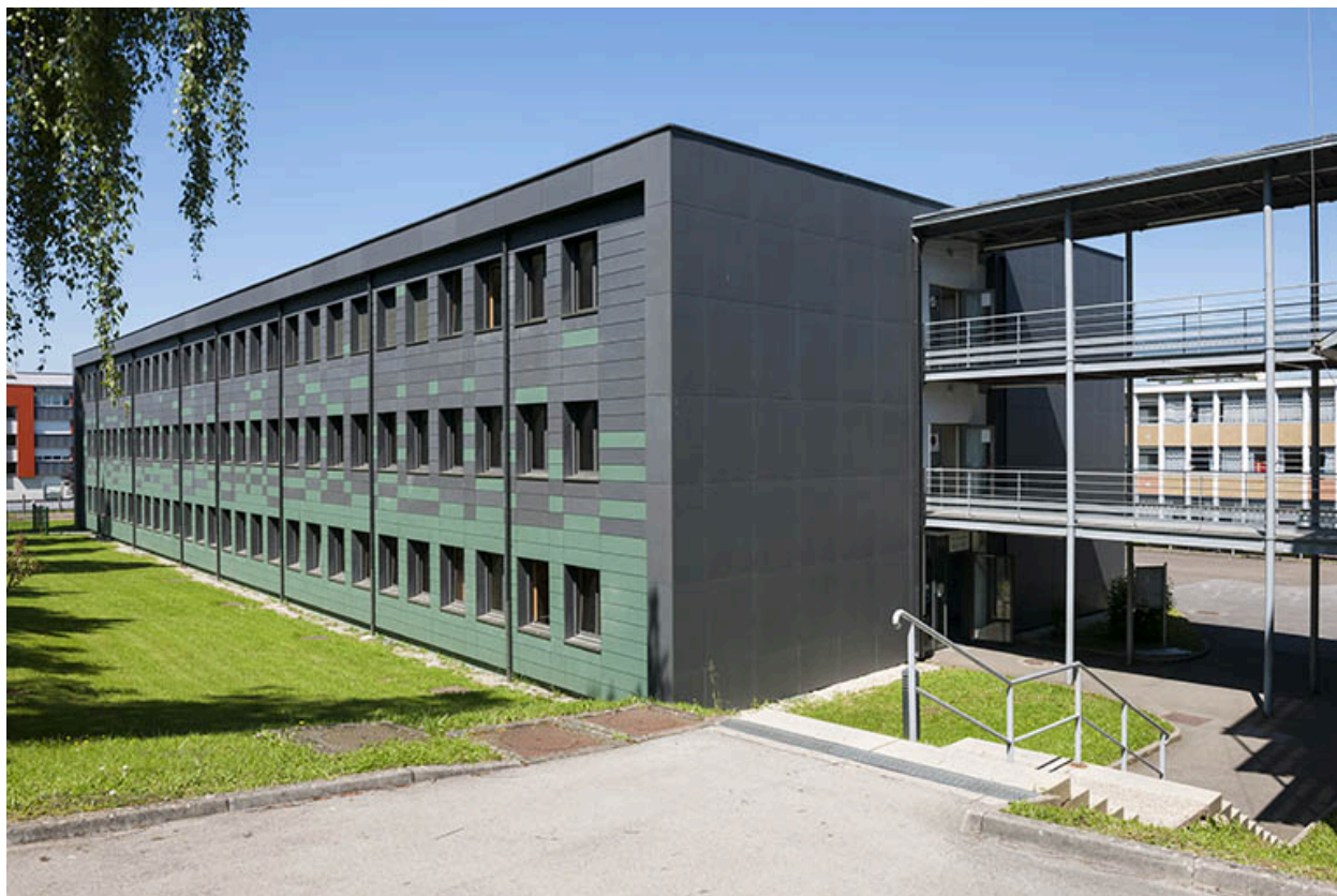
Façade sud et pignon est de l'externat.
