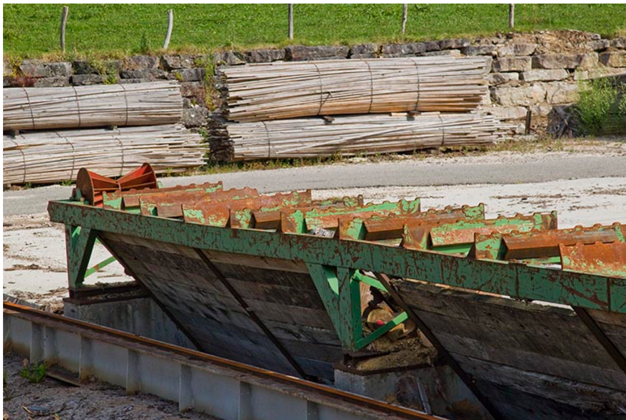
Parc aux grumes : détail du convoyeur.
