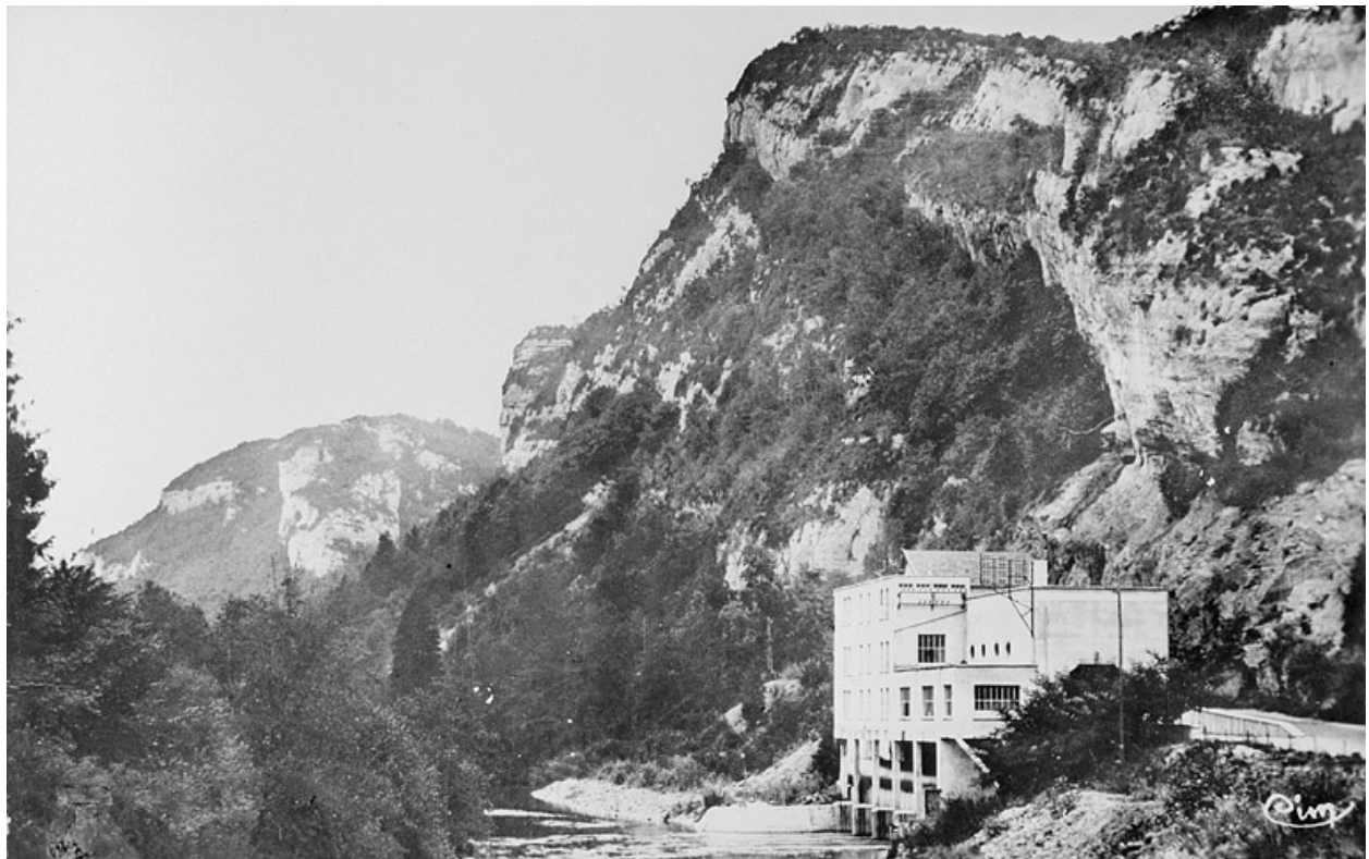
Chassal (Jura). Centrale électrique de St-Claude.
