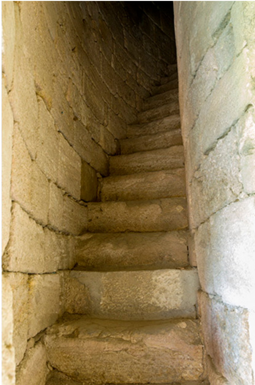
Intérieur du donjon : l'escalier en pierre.
