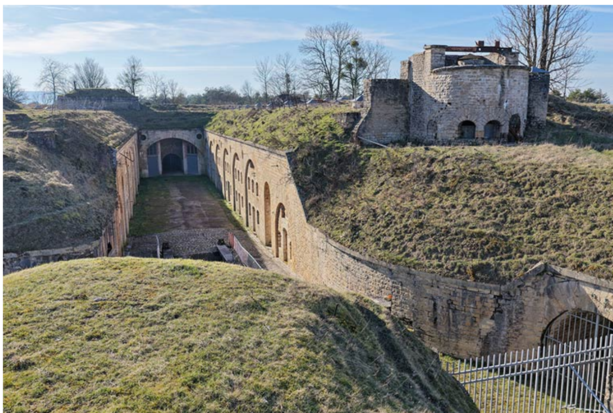
Les casernes (à gauche) et la tour de transmission (à droite). (vue aérienne).
