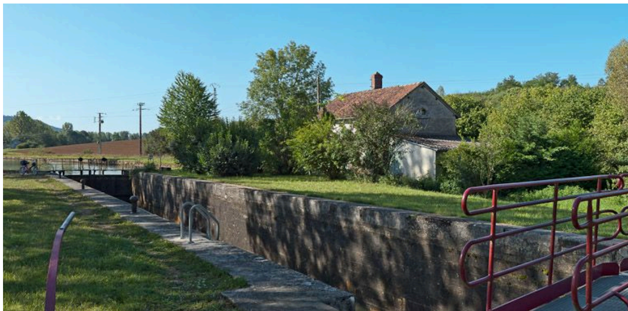
Vue d'ensemble du site d'écluse.
