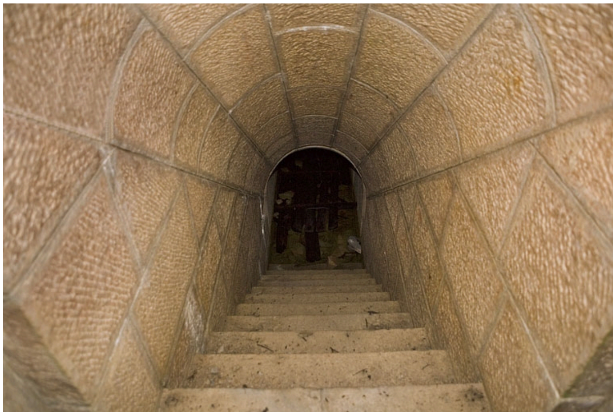
Chambres de mine centrale : escalier.
