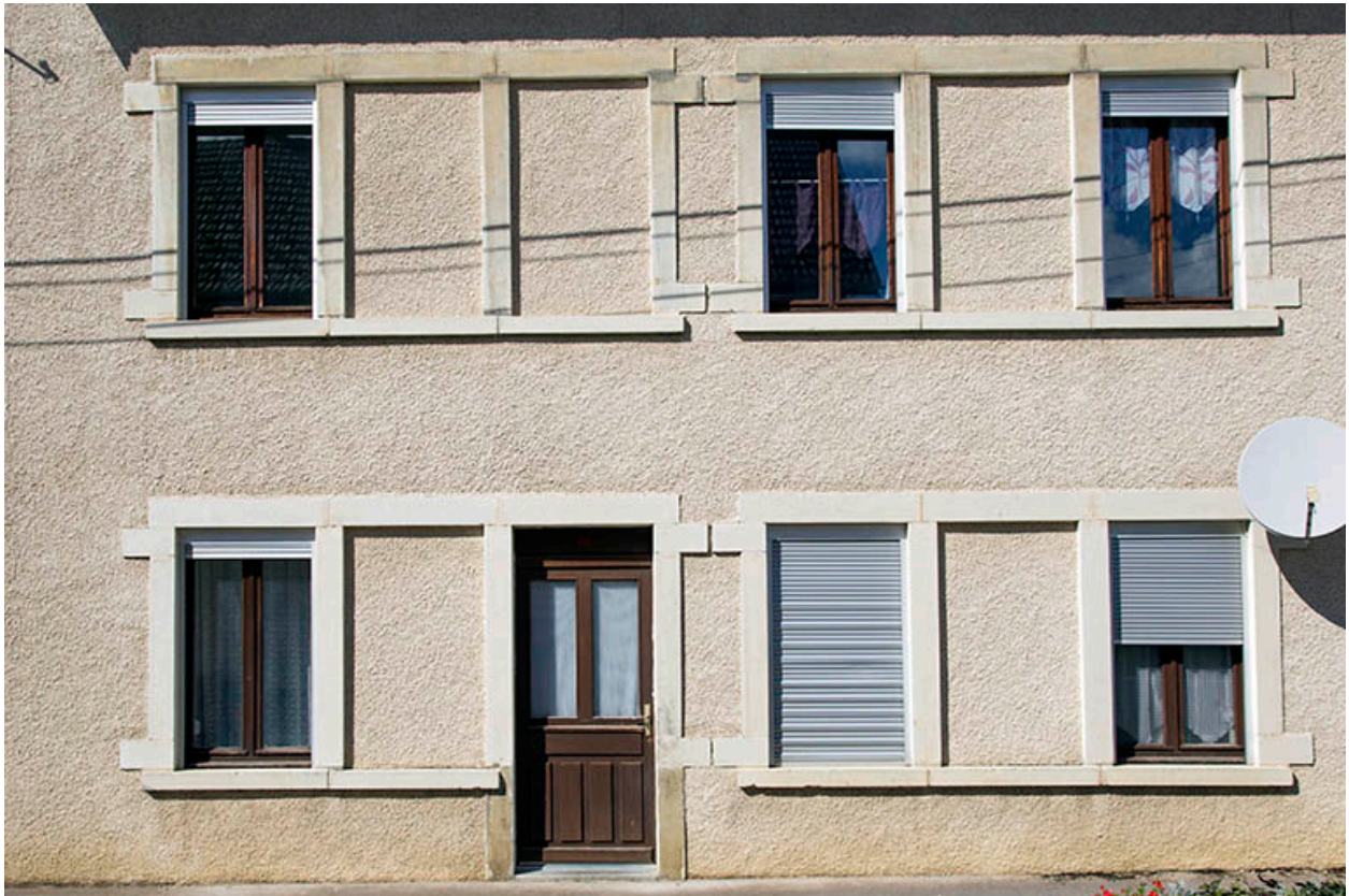
Façades antérieure des ateliers.
