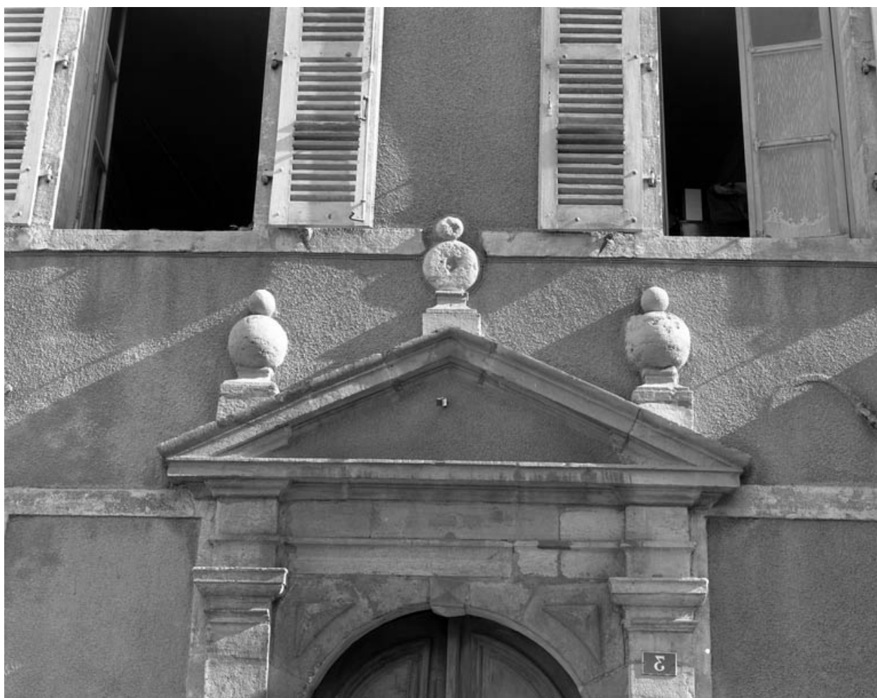
Portail d'entrée : détail du fronton.
