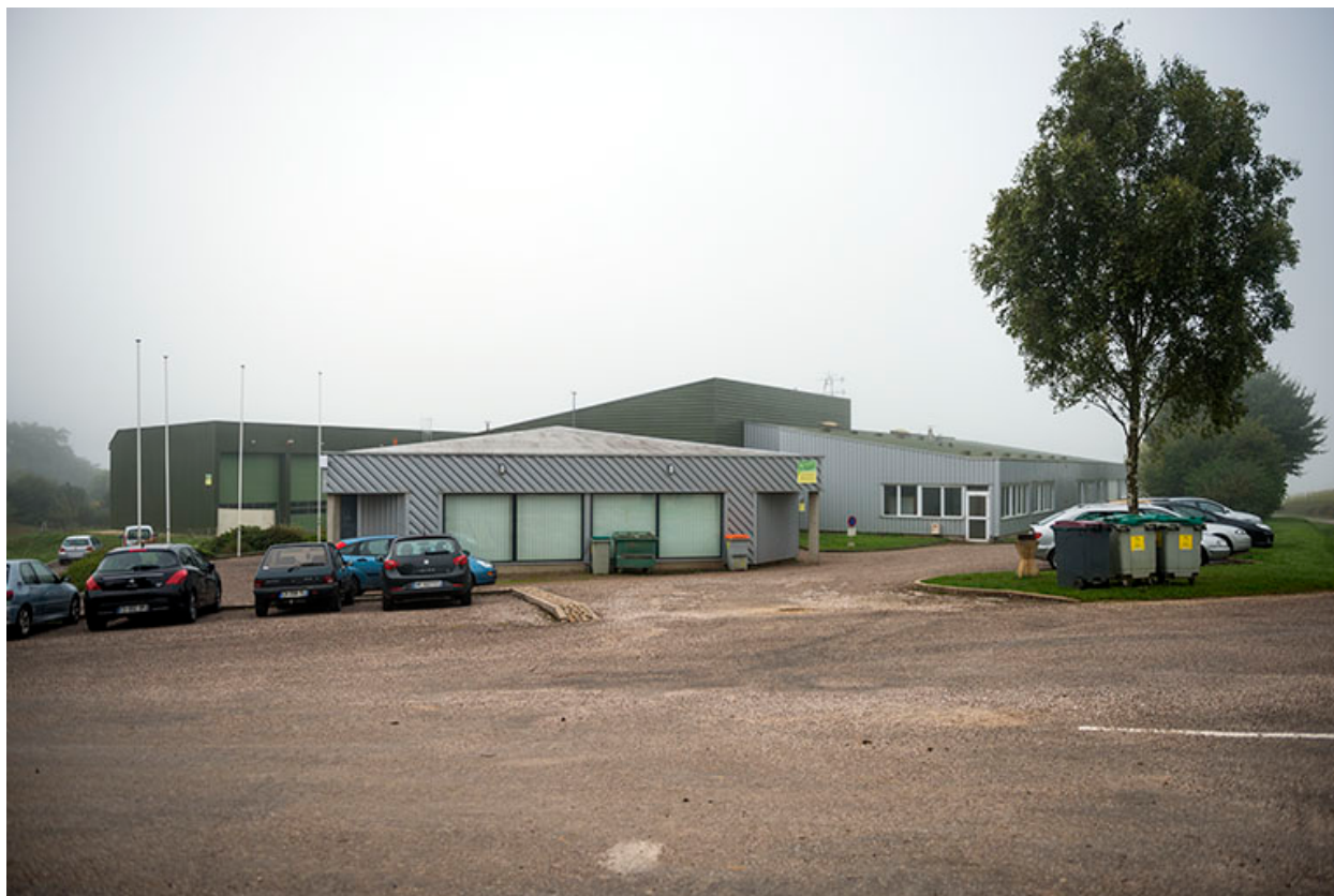
Façade nord-est du hall d'exposition.
