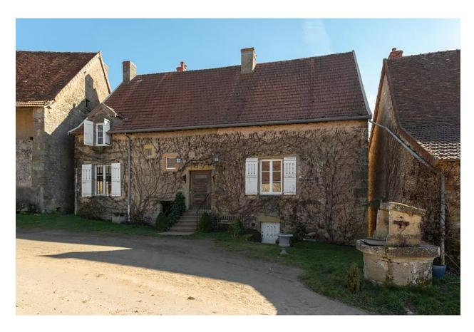
Façade antérieure de la maison. Les ruptures de l'enduit indique que le mur, en partie centrale, a été ajoutée postérieurement afin de fermer la cage d'escalier.
