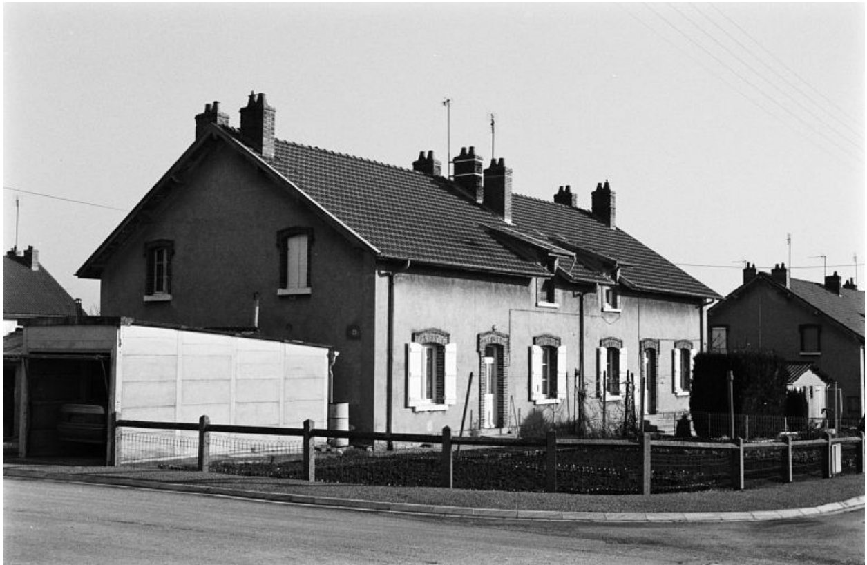
Habitation à quatre logements de quatre pièces de "type 1" (1913).
