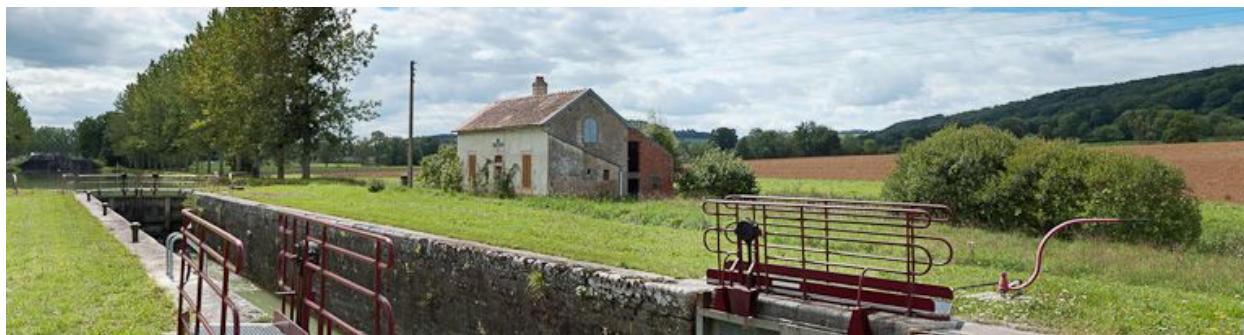
Vue d'ensemble du site d'écluse.
