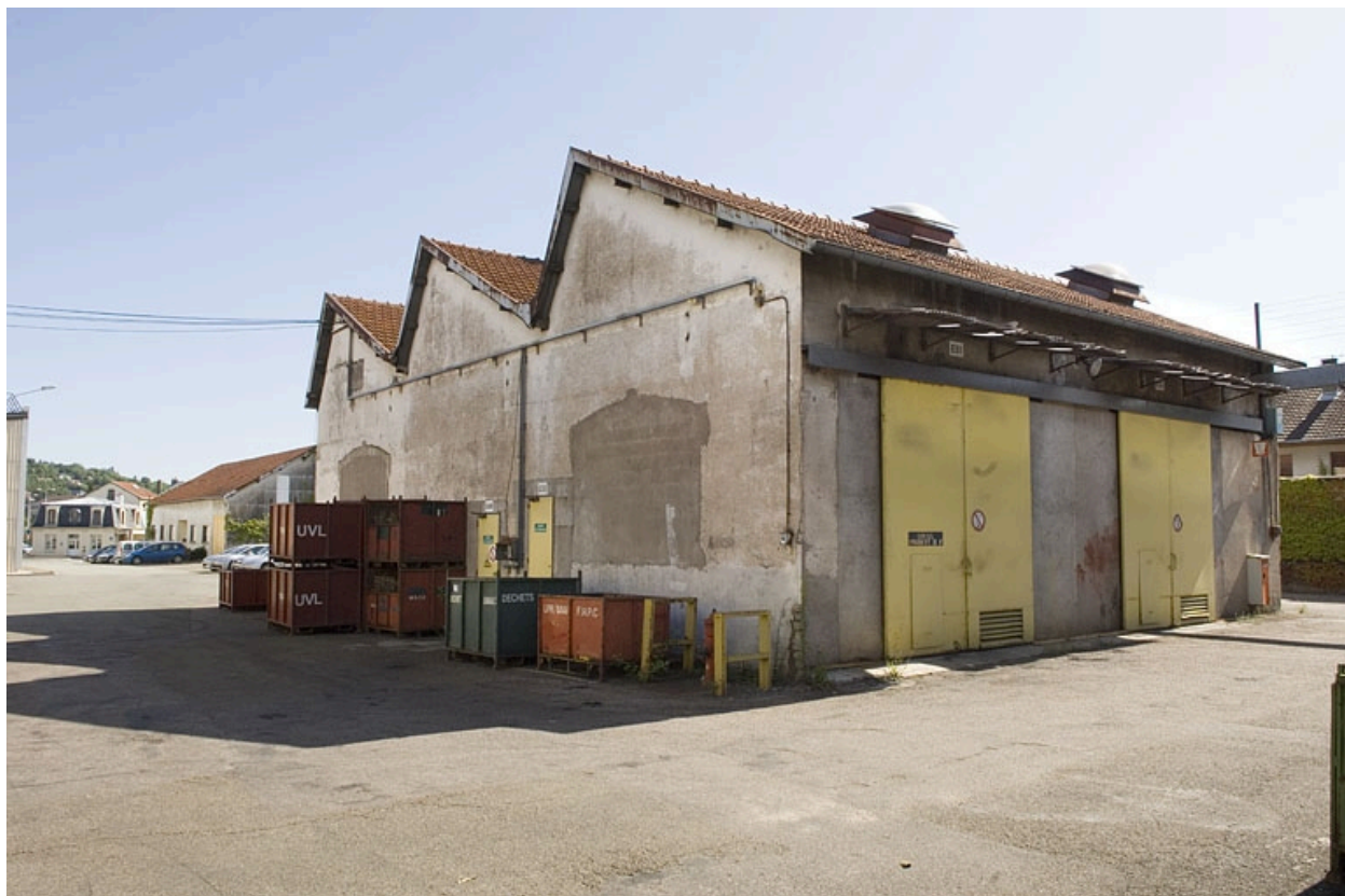
Salle des machines et chaufferie (usine Dollé).
