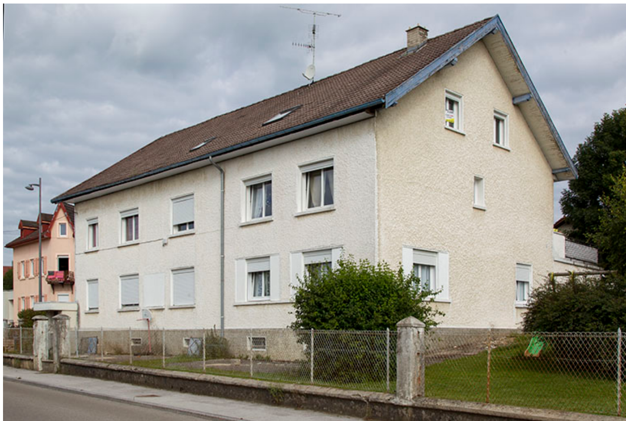
Façades antérieure et latérale droite.
