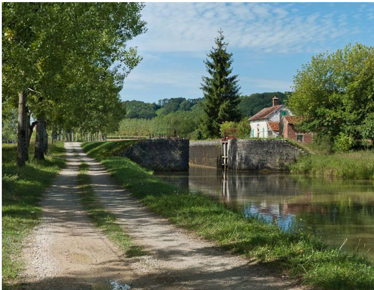
Vue du site d'écluse depuis l'aval.
