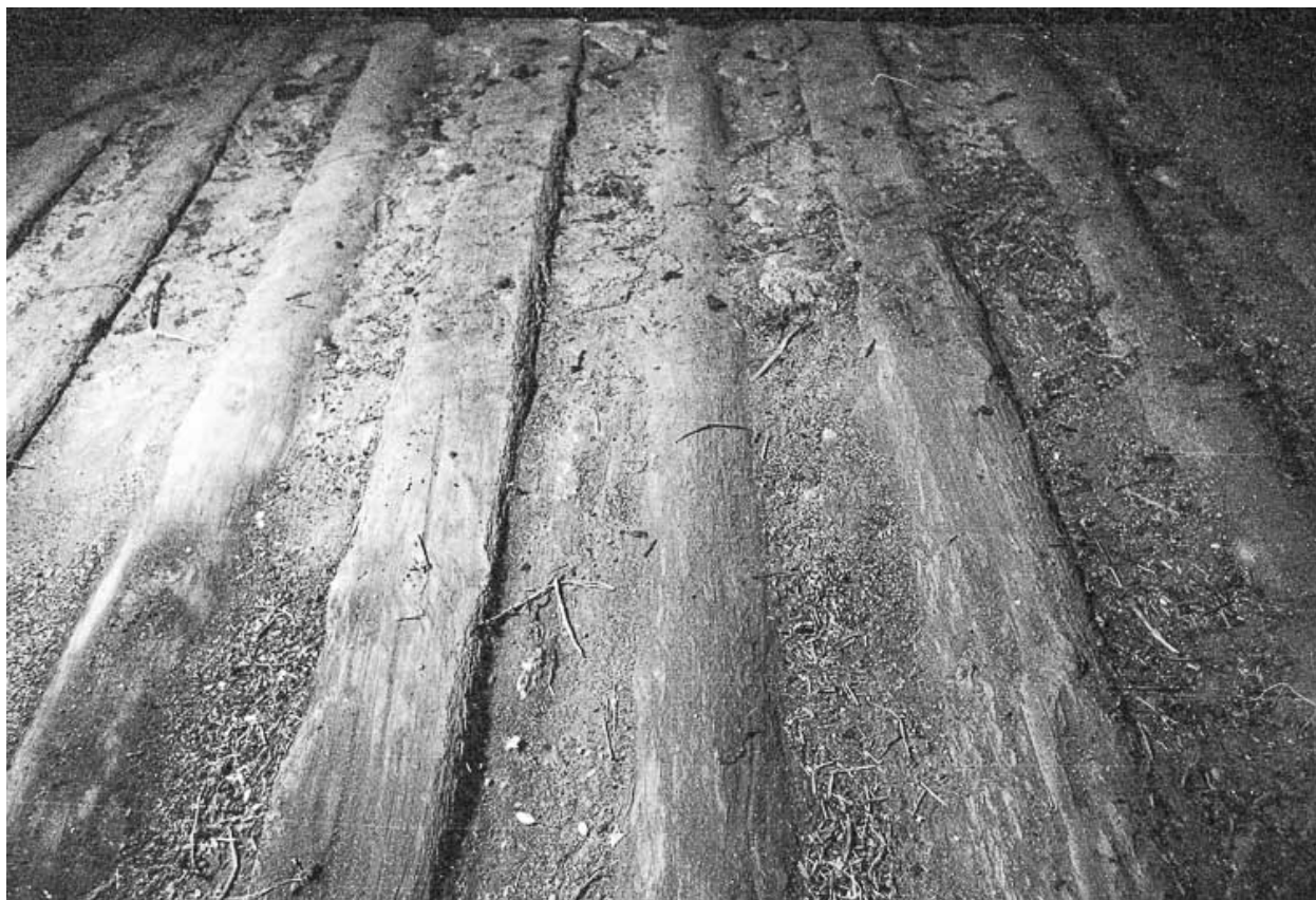
Ferme cadastrée 1965 AD : détail du plafond.
