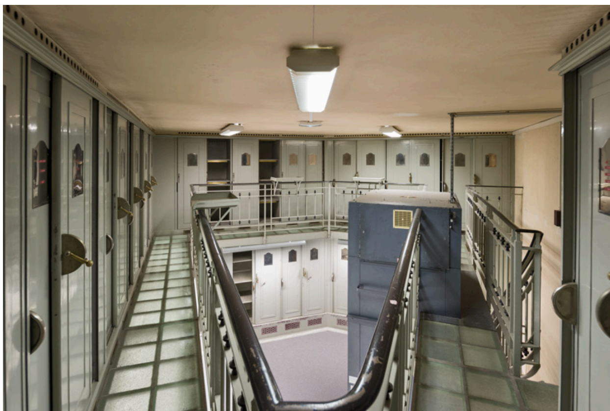
Caisse auxiliaire, armoires, coursives à garde-corps doté de tablettes mobiles.
